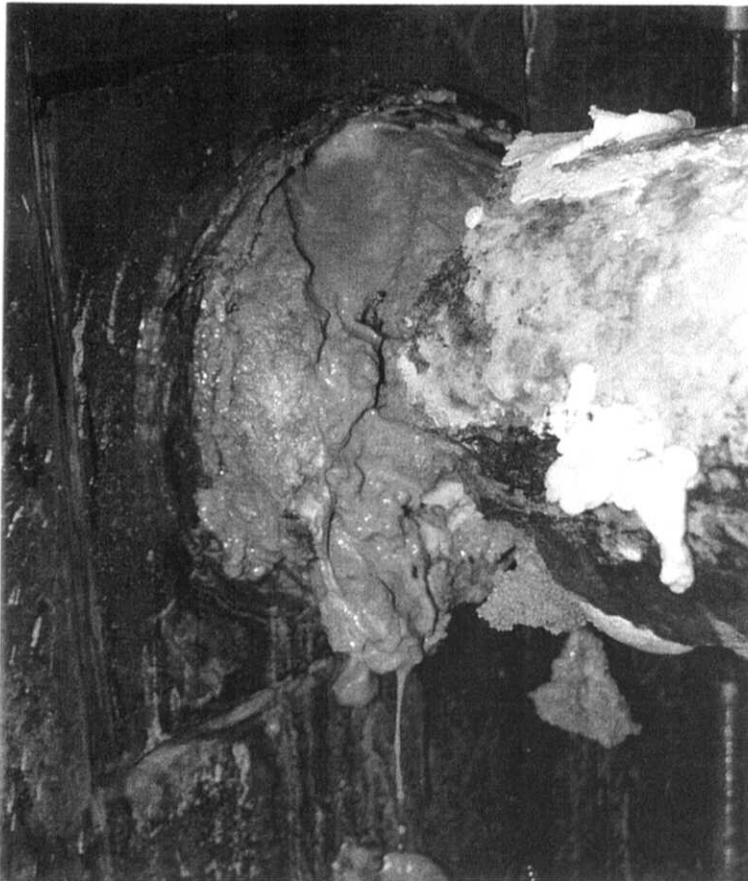
Bild 7: Sandausspülung bei 0,3 bar Wasserdruck nach Entfernen des Ankerrohres
